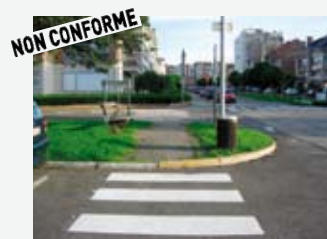
Traversée non conforme d'un terre-plein, car ne respectant pas le §3.
