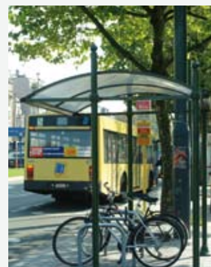
Stationnement vélo conforme.
