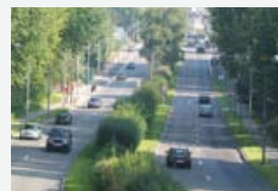
Voie du réseau primaire.
