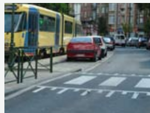
Traversée piétonne surélevée conforme.
