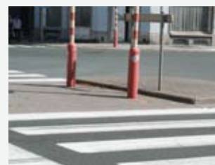
Traversée conforme d'un îlot directionnel.
