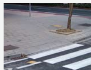
Traversée piétonne par un abaissement progressif.
